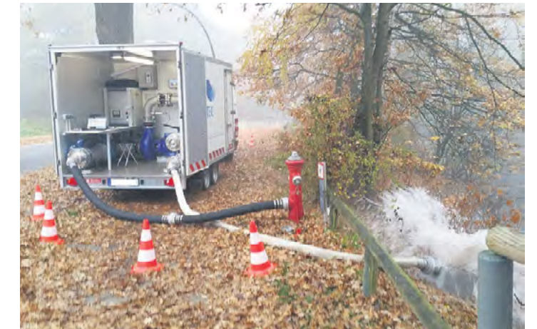
Mit patientierter Technik wird das Trinkwassernetz gespült.
