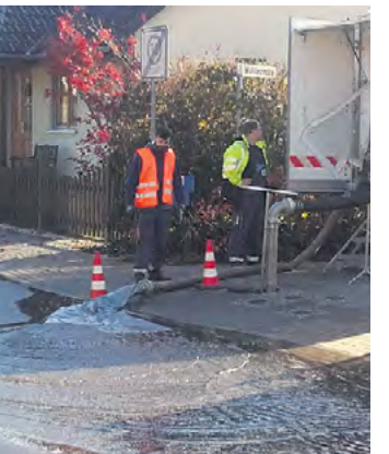
Gespültes Wasser wird in die Kanalisation eingeleitet. Fotos(2): Stadtwerke Bernau
