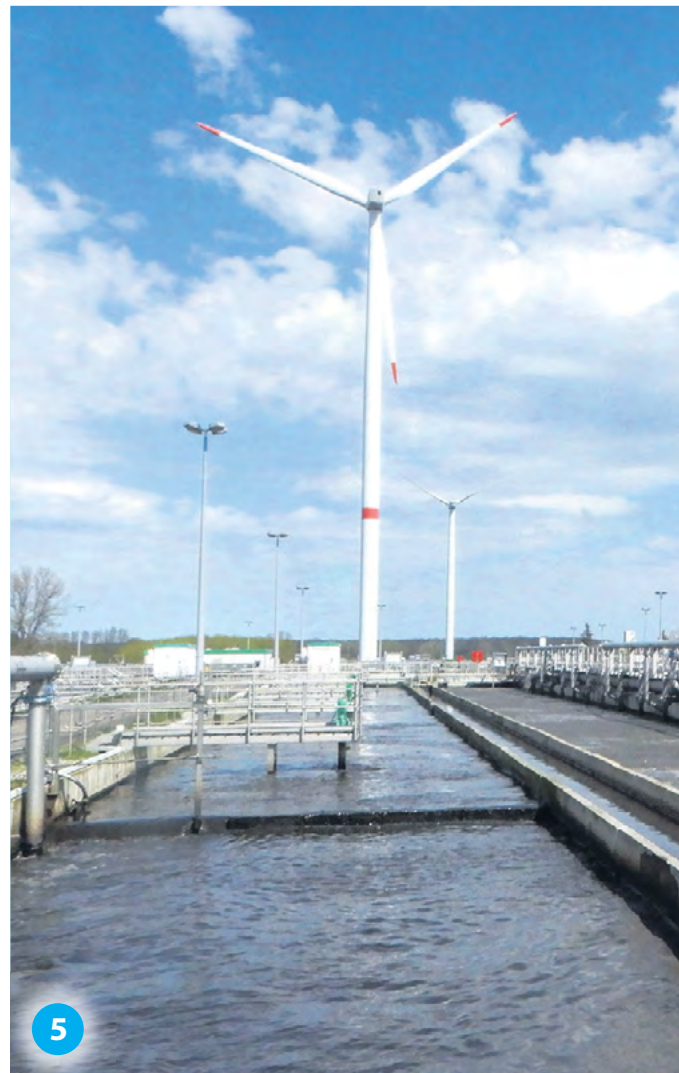
Wind und Klärgas liefern den Strom für die Anlage.
