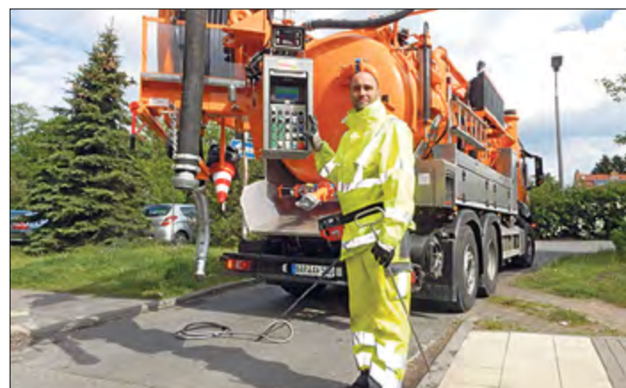
Modernste Technik sorgt für saubere Schmutzwasser-Kanäle.
