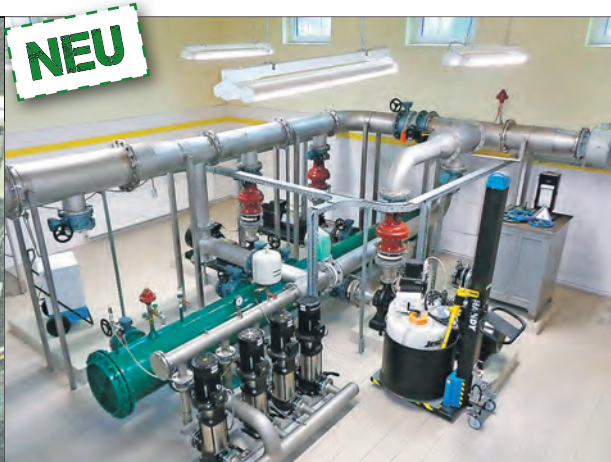
Die Druckerhöhungsstation nach der Sanierung.
