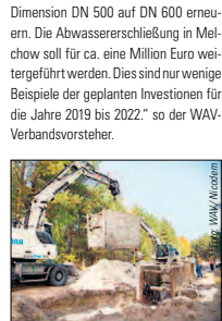
Auch 2019 drehen sich die Bagger beim WAV.
