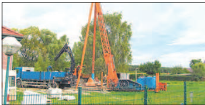
Ein neuer Brunnen für die Trinkwasserversorgung wurde in Schönow gebaut.
