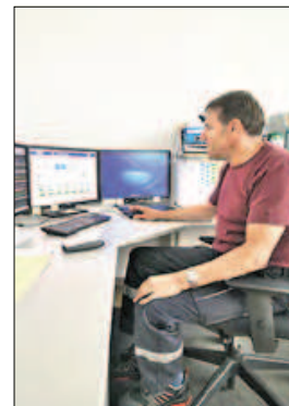
Herzstück der Wasserversorgung: Der Wasserwerker prüft den Puls des Betriebs.
